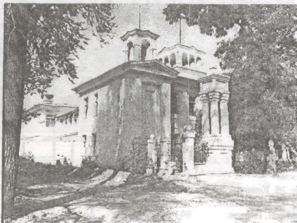
Рис. 24. Дворец пионеров, ул. Мичурина, 118, 1939 г. Арх. Ф. Стеблин. Завершен в 1951 г. Арх. В. Нусов.
